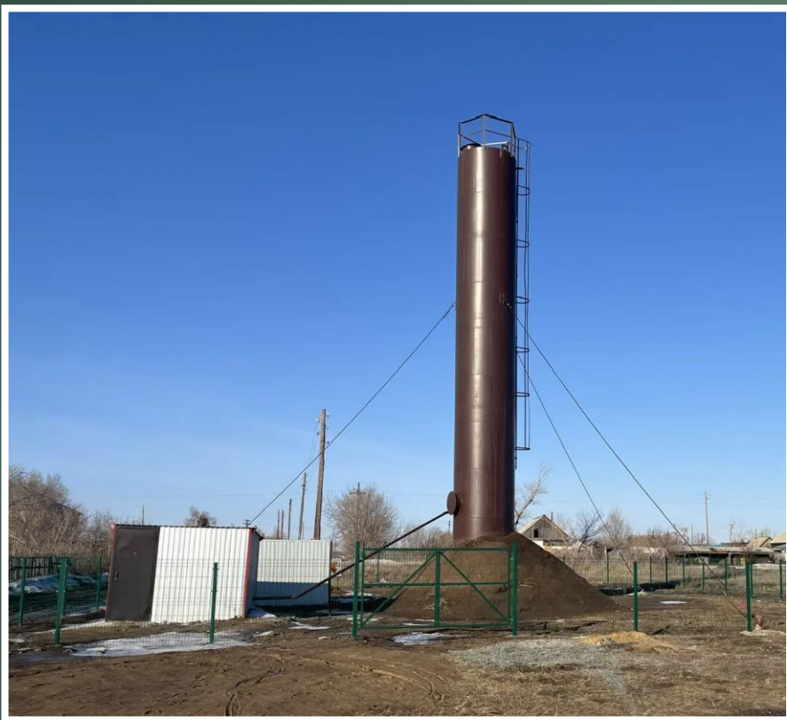
Капитальный ремонт водозаборного узла в с. Алтайское
