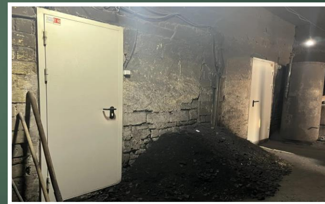
Капитальный ремонт котельной в с. Алтайское
